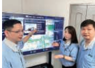
太陽光発電監視モニター
