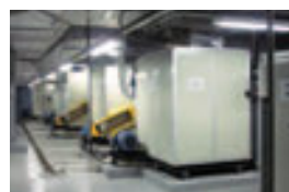
Alat hawa dingin dengan alat pemalut berkecekapan tinggi dipasang.
